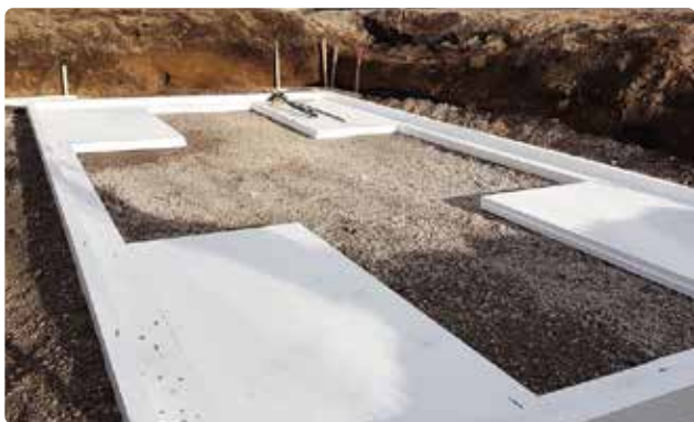
Bild 8. Börja med att lägga ut en hel cellplastskiva i varje hörn.
