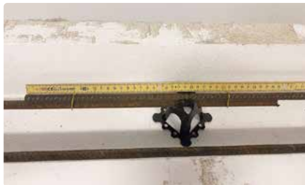
Bild 38. Armeringsjärnen ska skarvas 400 mm.
