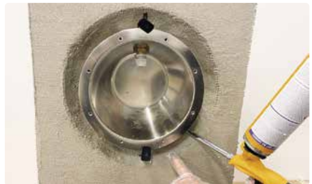
Bild 62. Skumma fast lamphuset med fogskum. Den putsade ursparningen ska inte fogskummas.
