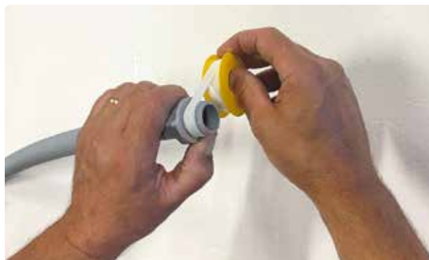
Bild 54. Gängtejpa kabelrörets gängor med ca 10 varv tejp.
