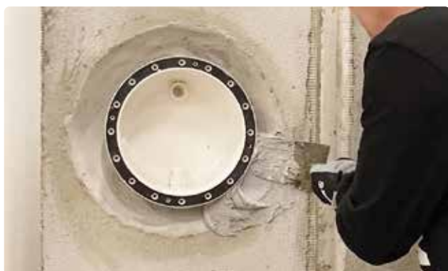
Bild 64. Adesilexmassan ska tryckas in i hela ursparningen.
