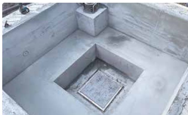
Bild 50. Färdigputsade väggar och sittbänkar. Golv ska ej putsas.
