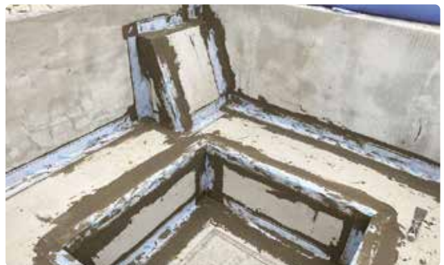
Bild 73. Tryck fast alla tätbanden och hörn med Mapelastic.
