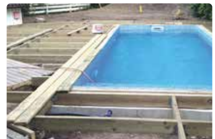
Bild 94. Plankorna till trädäcket fästs sedan i de monterade träbjälkarna.
