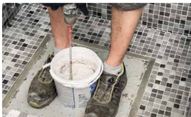
Bild 82. En lågvarvig maskinvisp kan med fördel användas.
