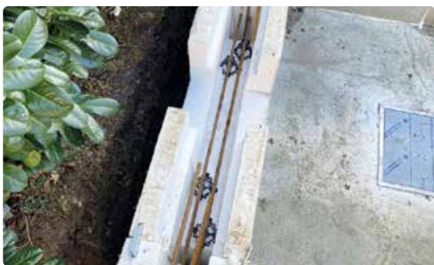
Bild 29. Armeringsjärnen ska ligga mellan två pelare och skarvas med 400 mm.
