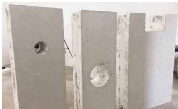
Bild 24. Block med urtag för inlopp, lampa och bräddavlopp.
