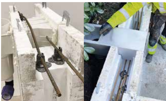
Bild 39. Armering vid bräddavlopp i plast respektive rostfritt.
