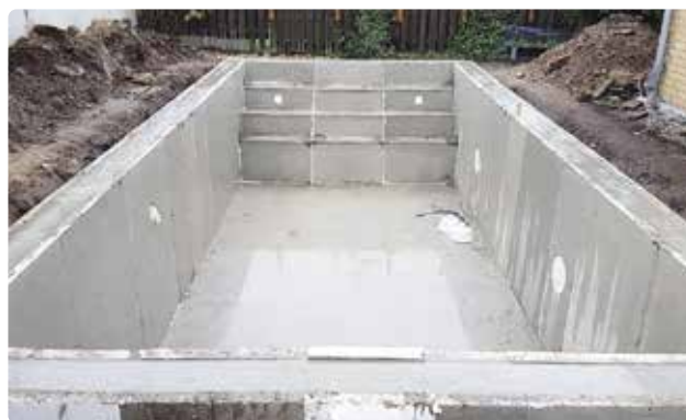
Bild 40. Pool med färdiggjutna väggar och krönbalk.
