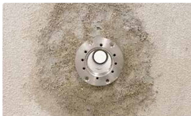
Bild 65. Adesilexmassa runt ett inlopp. Avsluta med ett fint lager sand på ytan in mot pool.
