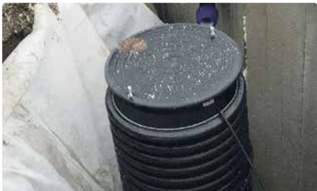
Bild 2. Dräneringsbrunn används för att leda bort vatten i marken.
