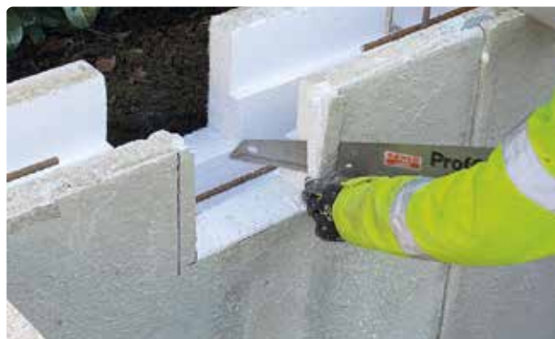
Bild 32. Skär ett konformat urtag 50×50 mm.
