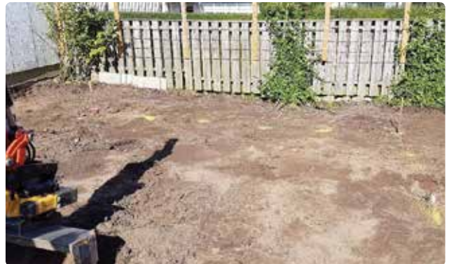
Bild 1. Markera schaktytan med färgspray.
