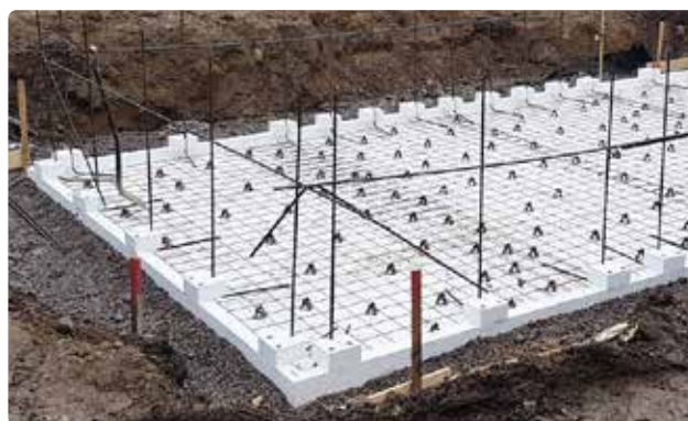
Bild 15. Armeringsvinklarna kan stabiliseras ytterligare genom att tillfälligt naja fast raka järn ca 1 m upp på armeringsvinklarna.
