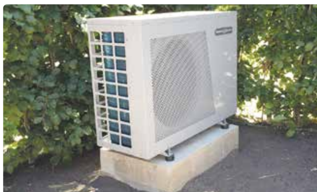
Bild 100. Värmepumpen ska stå utomhus och med god lufttillförsel.
