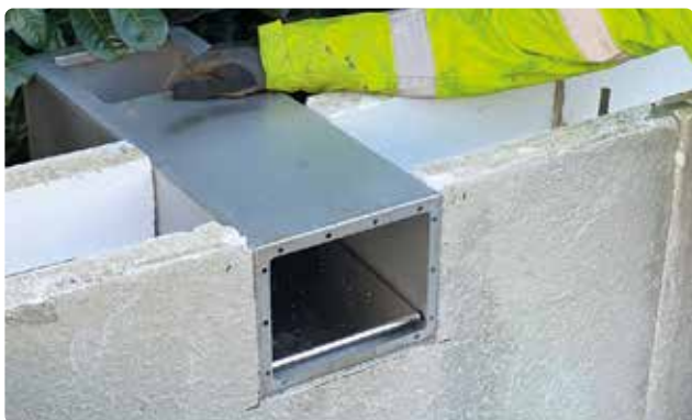
Bild 31. Kontrollera så att hålet för bräddavloppet är ok.
