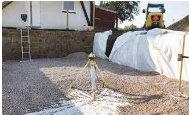
Bild 5. Avväg makadambädden med rotationslaser.
