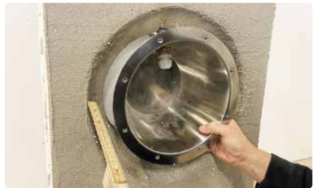
Bild 60. Mät hur mycket hållramen ska sticka ut. Den ska sticka ut lika mycket som klinker/mosaik+fix+tätskikt bygger tillsammans.
