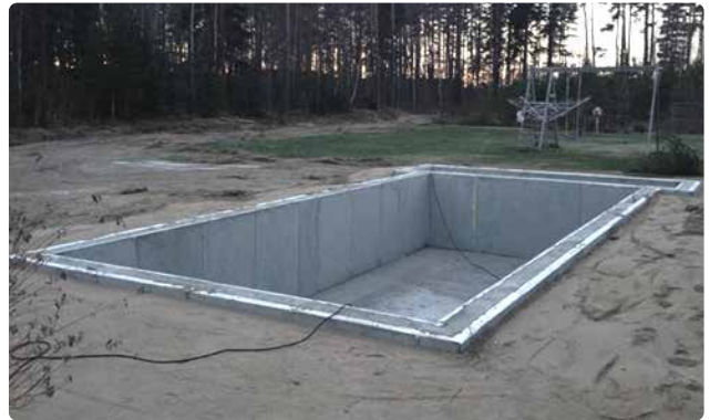
Bild 90. Helt återfylld pool.
