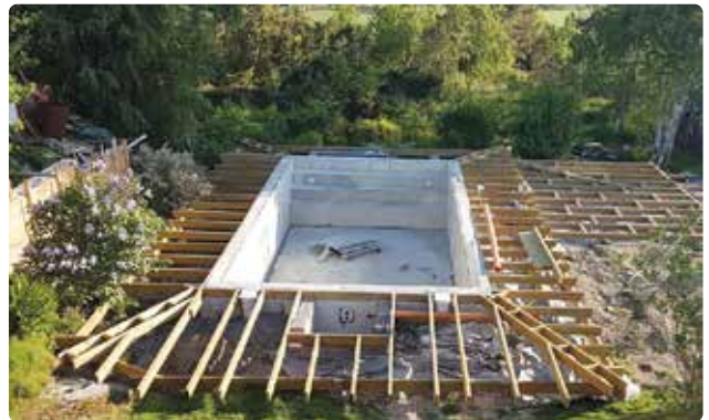
Bild 91. Trädäcket kan med fördel fästas i poolens krönbalk.
