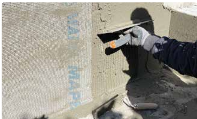
Bild 45. Applicera ett jämnt skikt av bruket och dra sedan ut det med tandad spackel.
