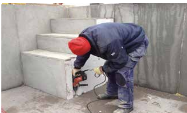
Bild 34. Expanderbult skruvas fast i betongplattan i varje urtag.
