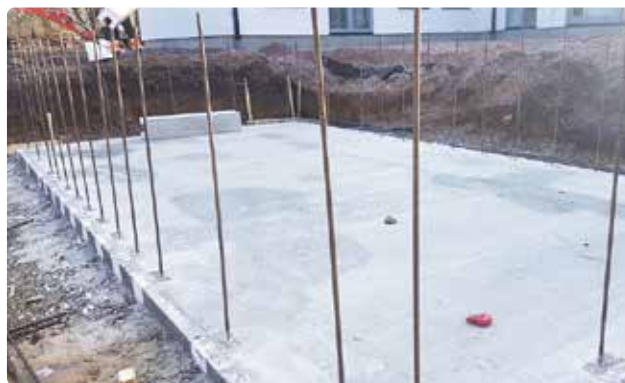
Bild 19. Cellplastklossarna plockas bort när betongen härdat.
