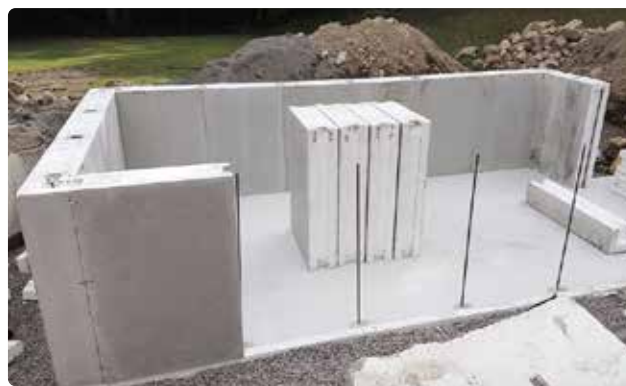
Bild 23. Det är en fördel att avsluta monteringen med ett hörn.
