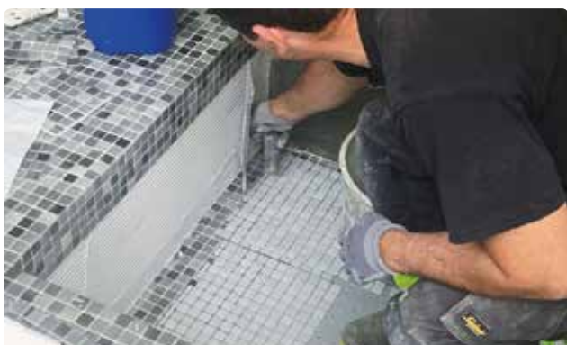
Bild 77. Applicera 6 mm spackel på ca 1 m 2 åt gången.
