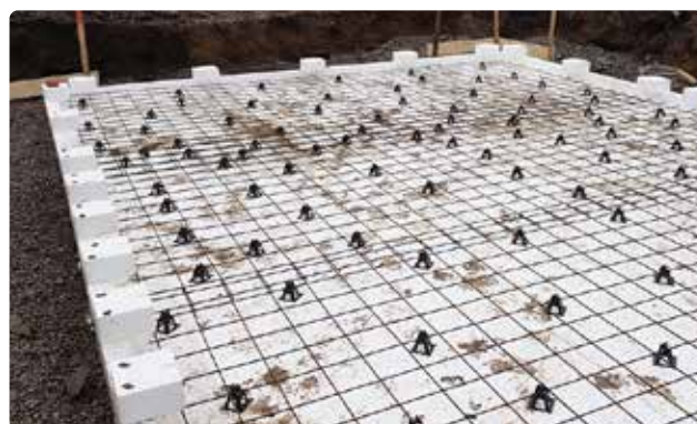
Bild 11. Placera cellplastklossar vid varje markering för pelare.
