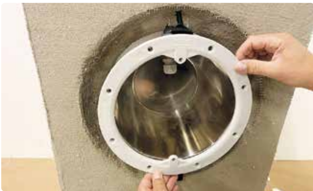
Bild 59. För att lampan ska sitta rakt ska kabelröret vara rakt upp. I detta fall kan kontroll mot Pahlén-logga göras.
