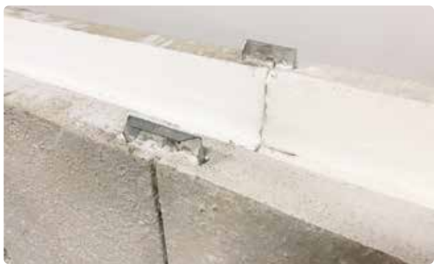
Bild 22. Fäst ihop poolväggarna med skarvbleck i ovkant.
