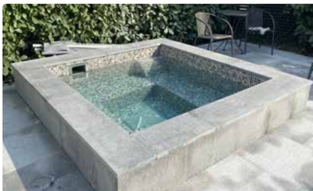
Bild 101. Vattnet ska fyllas på långsamt i poolen.
