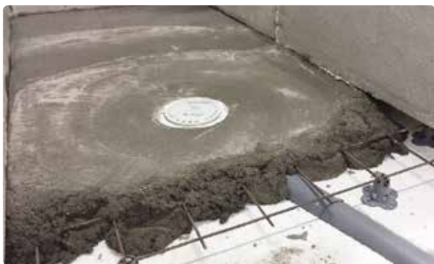
Bild 18. Om teknikrummet byggs i anslutning till poolen ska en golvbrunn gjutas in.
