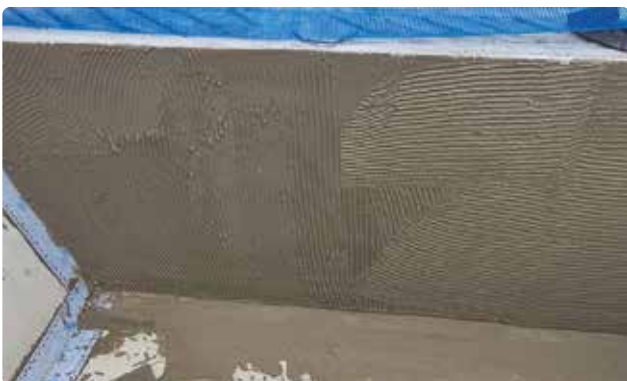
Bild 74. Dra ut Mapelastic med 6 mm tandad spackel.
