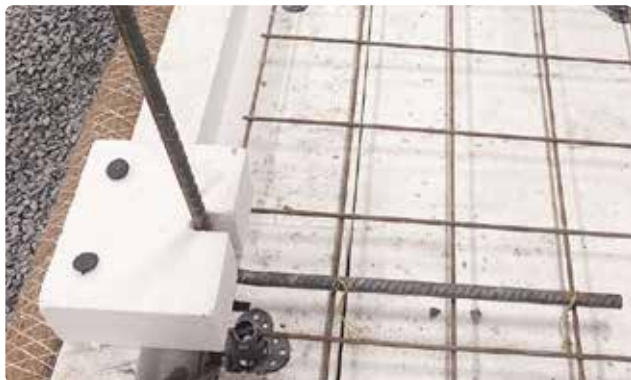
Bild 12. Placera armeringsvinkeln i cellplastklossens spår.
