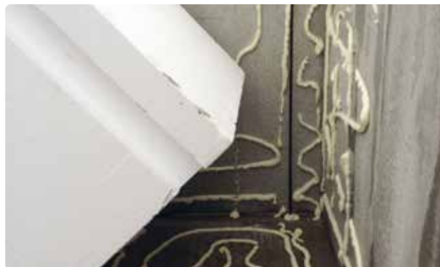
Bild 36. Trappblocken monteras på plats med fogskum. Därefter gjuts urtagen.
