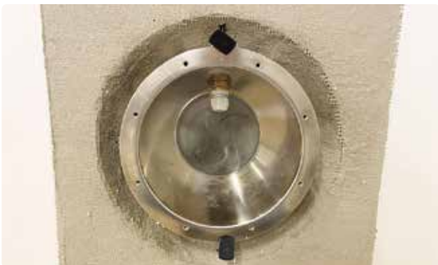
Bild 61. Stabilisera lampan genom att klossa upp den med t ex lite cellplast i underkant och stötta med t ex två cellplastspikar.
