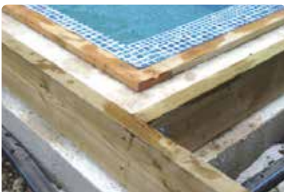
Bild 92. Cellplasten skärs ner och träreglar fästs runt poolen.
