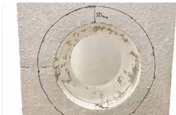
Bild 41. Mät ut för Adesilex-ursparning som ska vara 50 mm bred och 50 mm djup.
