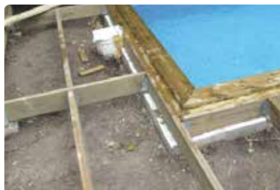
Bild 93. Träbjälkarna till trädäcket fästs i träregeln.
