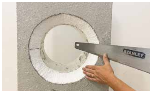
Bild 42. Ursparningen för Adesilex kan sågas med fogsvans.
