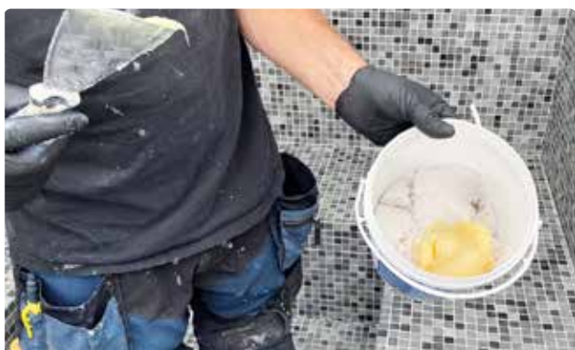
Bild 81. Blanda komponent A och B enligt anvisning.
