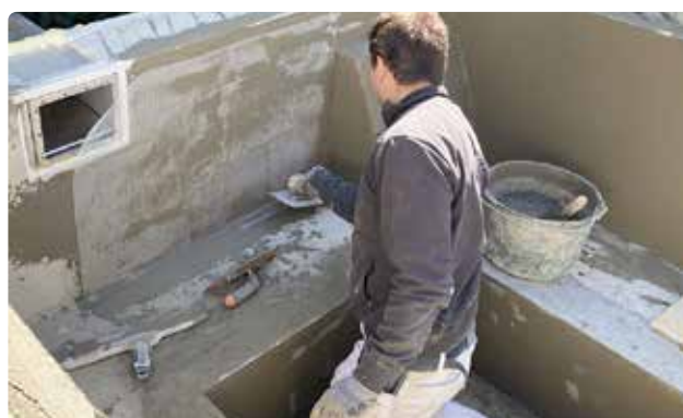
Bild 48. Bygg på med bruk så att 8 mm bruktjocklek uppnås.
