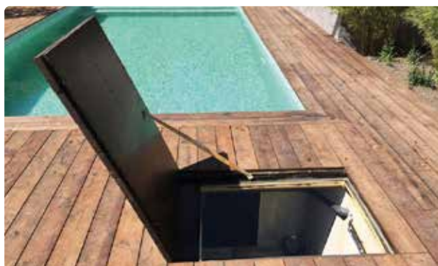
Bild 98. Exempel på lösning med lucka till nedgrävt teknikrum.
