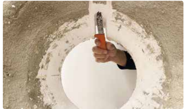
Bild 58. Skär ur urtag från baksida block.
