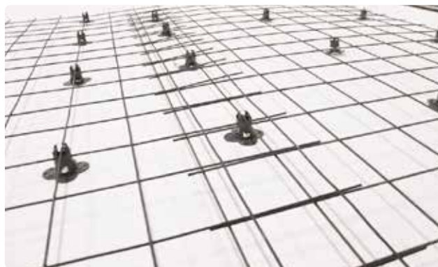
Bild 9. Armeringsnät skarvas med 200 mm överlapp.
