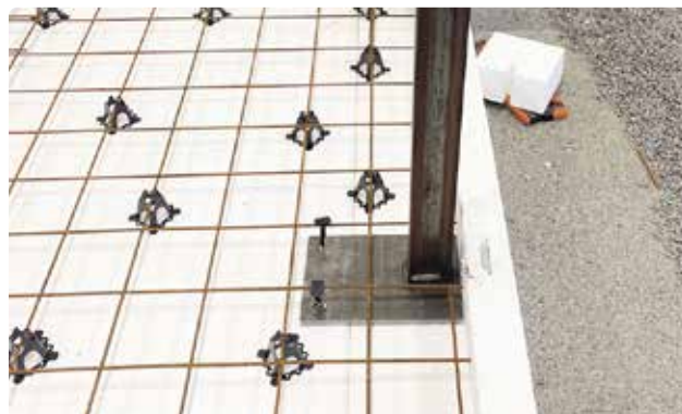
Bild 17. Placera bottenplattan kant i kant med insida L-element.
