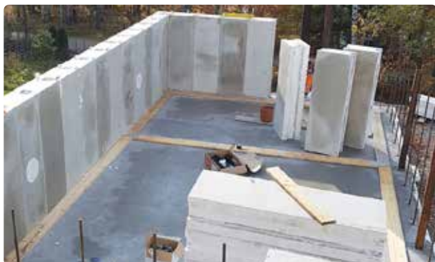
Bild 16. Förstärkningspelare används vid förstärkt pool.
