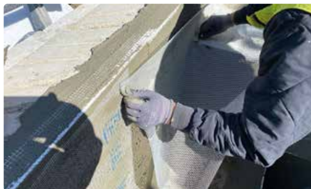
Bild 46. Bädda in vävvinklar och nät i bruket med en slät spackel.
