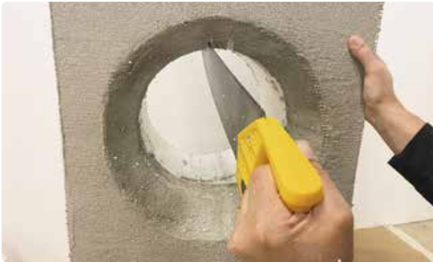
Bild 57. Måtta hur mycket kabelröret sticker upp och skär ett spår med en fogsvans.
