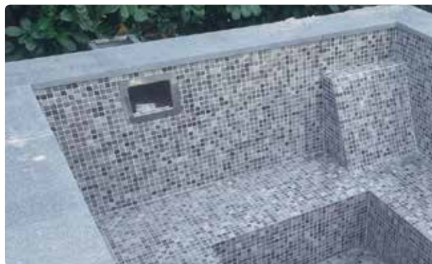
Bild 86. Färdigmonterat bräddavlopp.
