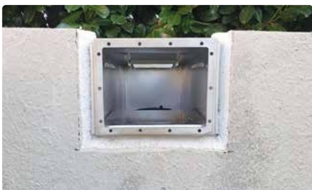
Bild 33. Ursparningen ska senare tätas med Adesilex PG1.
