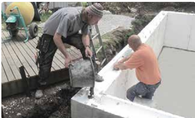
Bild 37. Fyll pelarna med bruk i två omgångar så att betongen hinna sätta sig i botten.
