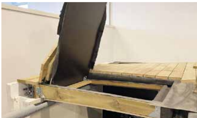
Bild 95. Ingång till teknikrum genom en lucka i trädäcket.
