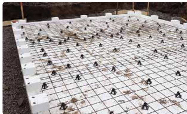
Bild 11. Placera cellplastklossar vid varje markering för pelare.
