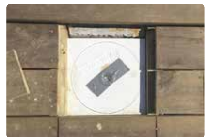
Bild 90. För att få vaccum måste bräddavloppet tejpas för.
