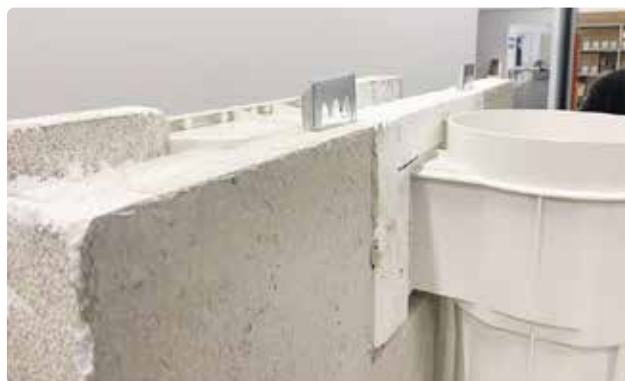
Bild 32. Tryck dit cellplastbiten och fäst den med skarvbleck i ovkant.
