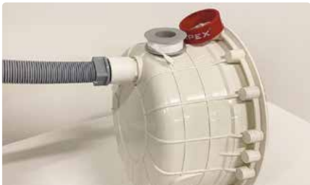
Bild 49. Det är viktigt att gängtejpa gängorna mellan kabelrör och vita pluggen.
