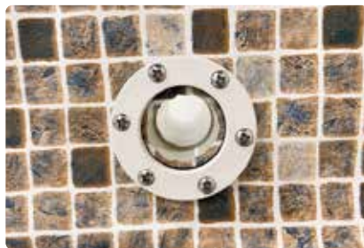
Bild 96. Linern i inloppshålet skärs bort.
