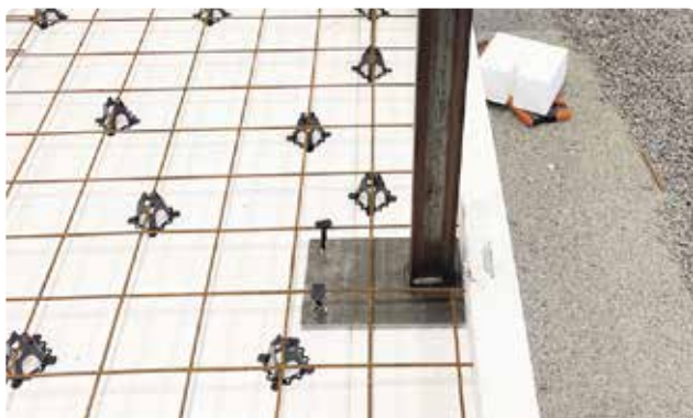
Bild 16. Placera bottenplattan kant i kant med insida L-element.
