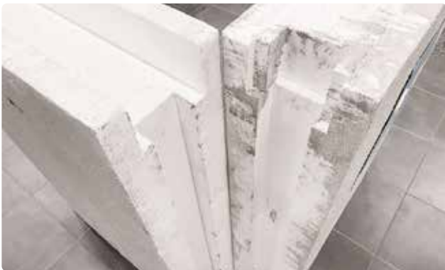
Bild 20. Börja med att montera ett innerhörn av två väggblock.
