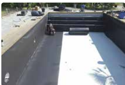
Bild 82. Skyddsduken monteras på botten.
