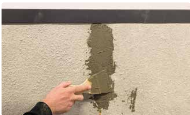
Bild 55. Spackla skarvarna med en bredspackel.
