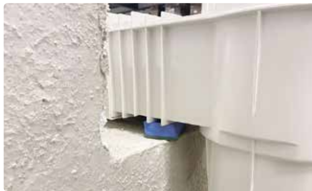
Bild 30. Klossa upp mellan block och bräddavlopp med justeringsbrickor så att bräddavloppet hamnar rakt.
