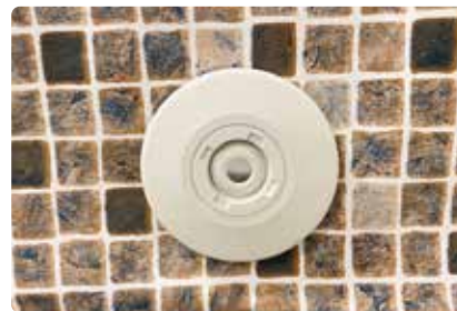
Bild 97. Inloppsmunstycket monteras på tätningsringen. Gångorna gängtätas.
