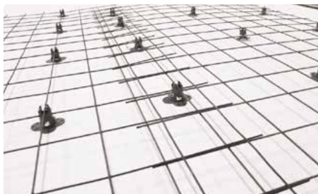
Bild 9. Armeringsnät skarvas med 200 mm överlapp.
