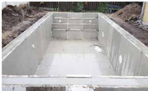
Bild 45. Pool med färdiggjutna väggar och krönbalk.
