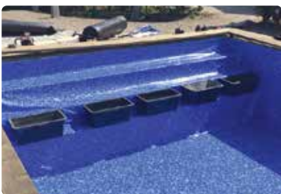
Bild 88. Tyngder placeras i trappan för att hålla linern på plats.
