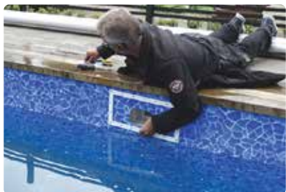
Bild 98. Montering av tätningsramen.
