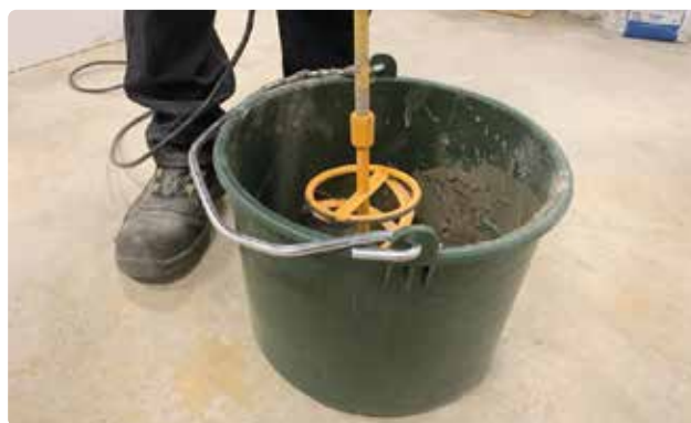
Bild 54. Blanda spacklet enligt anvisningar på säcken.
