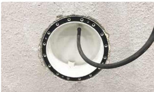
Bild 51. Lampa fastskummad från insida pool.
