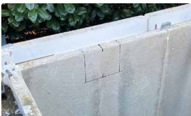
Bild 35. Markera och skär ut för bräddavloppet.
