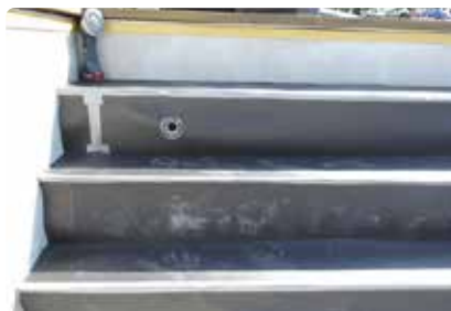
Bild 77. Trappnosen kan skarvtejpas och förstärkas med silvertejp.
