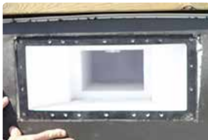
Bild 80. Skyddsduk vid bräddavlopp.
