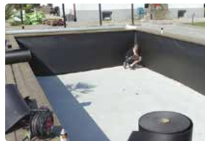
Bild 78. Efter trappan monteras skyddsduken på väggarna.
