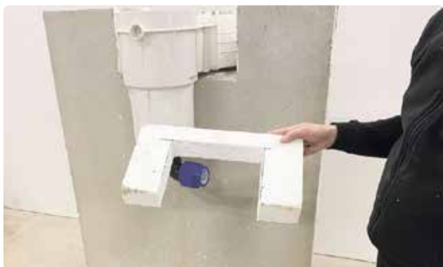
Bild 31. Skär ur en bit cellplast från klossen som tagits bort och fyll ut urtaget bakom bräddavloppet.
