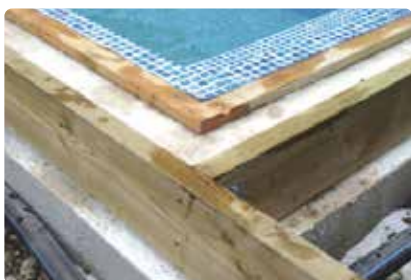
Bild 64. Cellplasten skärs ner och träreglar fästs runt poolen.
