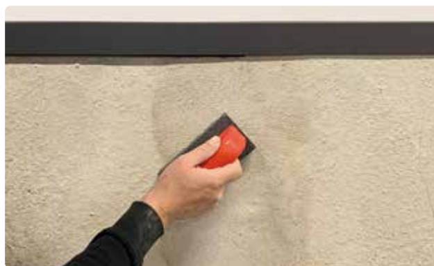
Bild 56. Slipa den torkade ytan med handslipsten.
