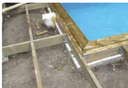
Bild 65. Träbjälkarna till trädäcket fästs i träregeln.
