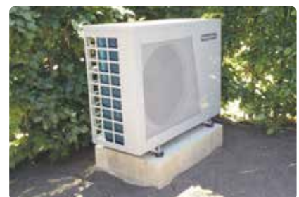
Bild 74. Värmepumpen ska stå utomhus och med god lufttillförsel.
