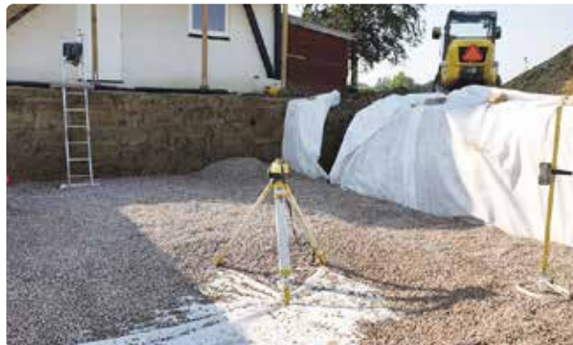
Bild 5. Avväg makadambädden med rotationslaser.
