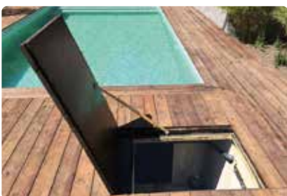
Bild 72. Exempel på lösning med lucka till nedgrävt teknikrum.
