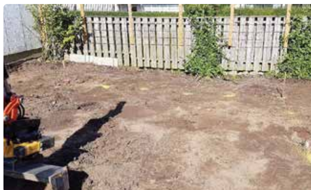
Bild 1. Markera schaktytan med färgspray.
