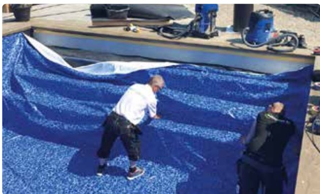
En fabrikssvetsad liner anpassas efter poolstorlek och trappa.
