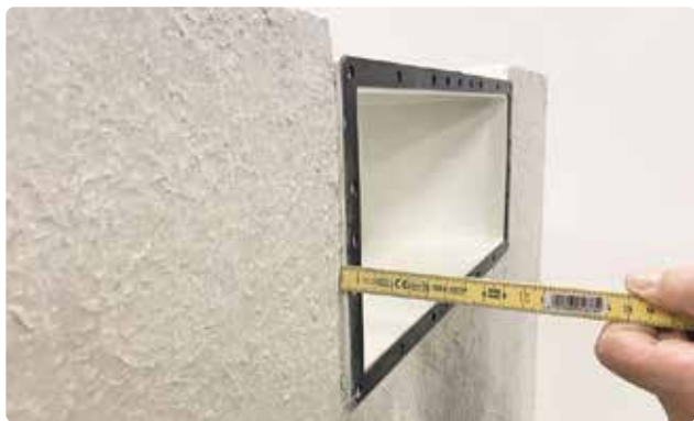
Bild 29. Placera bräddavloppet så den svarta gummitätningen hamnar i linje med insida liner.
