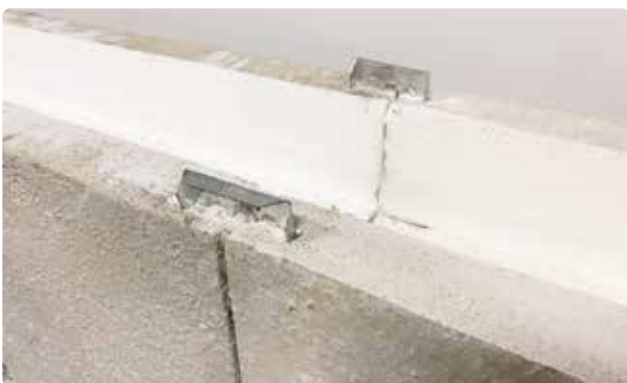
Bild 22. Fäst ihop poolväggarna med två st skarvbleck i ovkant.
