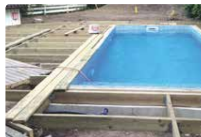
Bild 66. Plankorna till trädäcket fästs sedan i de monterade träbjälkarna.
