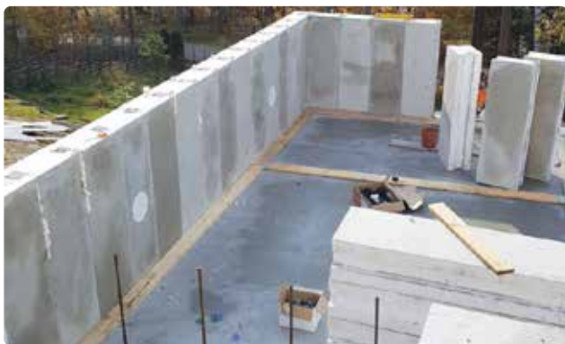
Montering av poolväggar.
