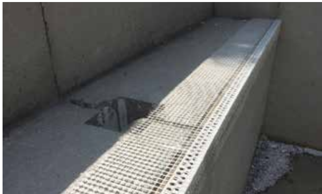
Bild 57. Vävinklar används för att få en rak trappstegskant.
