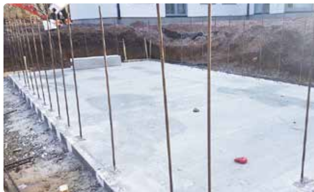
Bild 19. Cellplastklossarna plockas bort när betongen härdat.
