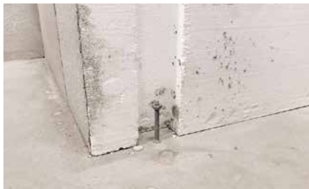
Bild 40. När bulten gjuts in i betongen fås en mekanisk förankring av trappan.
