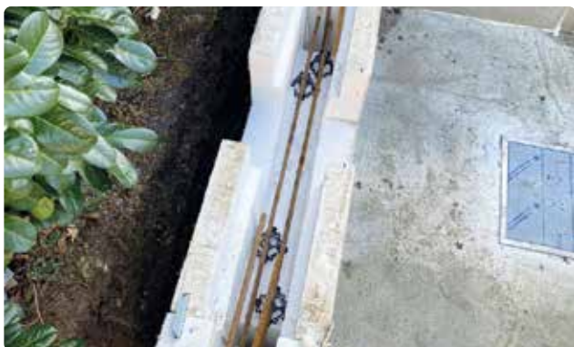
Bild 37. Armeringsjärnen ska ligga mellan två pelare och skarvas med 400 mm.
