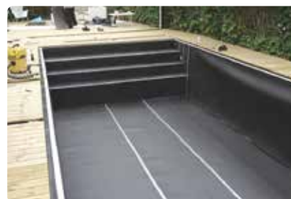
Bild 84. Färdigmonterad skyddsduk.
