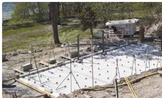
Bild 17. Förstärkningspelare vid fristående (ej nedgrävd) pool.
