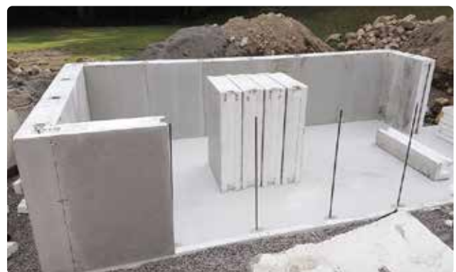
Bild 23. Det är en fördel att även avsluta monteringen med ett hörn.
