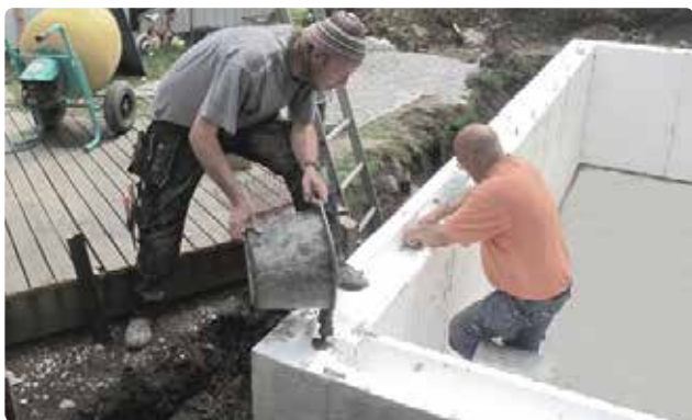
Bild 42. Fyll pelarna med bruk i två omgångar så att betongen hinner sätta sig i botten.
