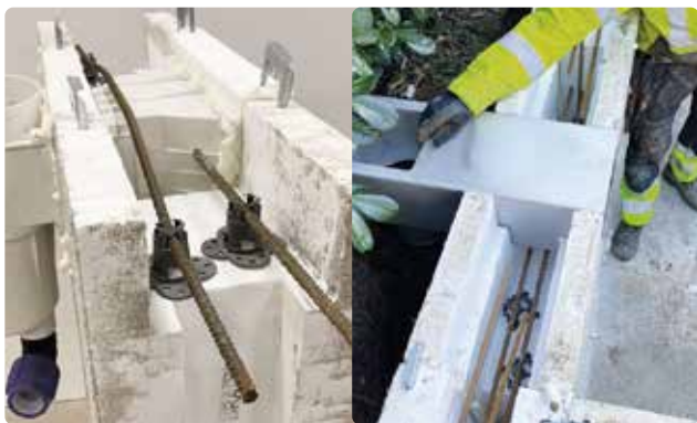
Bild 44. Armering vid bräddavlopp i plast respektive rostfritt.
