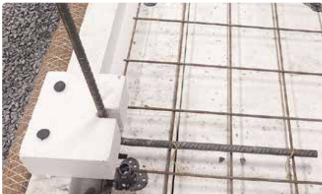
Bild 12. Placera armeringsvinkeln i cellplastklossens spår.
