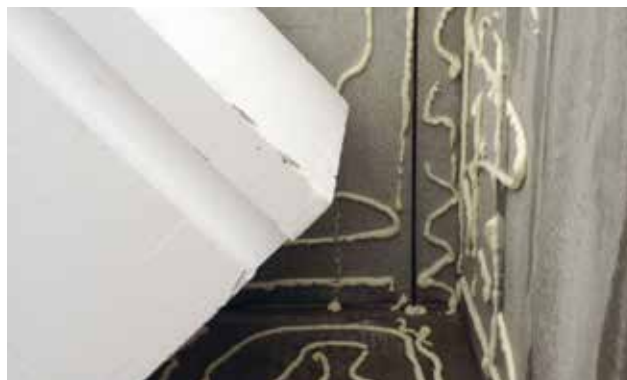
Bild 41. Trappblocken monteras på plats med fogskum. Därefter gjuts urtagen.
