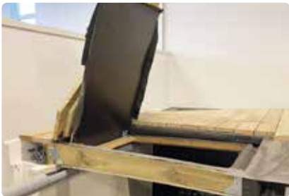
Bild 69. Ingång till teknikrum genom en lucka i trädäcket.
