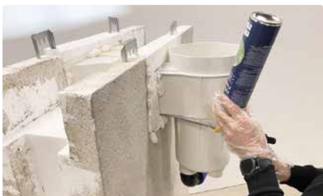
Bild 33. Fogskumma fast cellplasten vid bräddavloppet.
