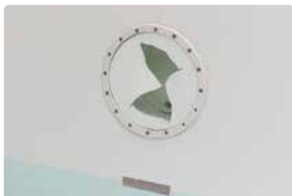
Bild 92. Skruva fast tätningsringen genom linern.
