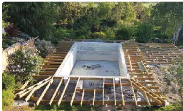
Bild 63. Trädäcket kan med fördel fästas i poolens krönbalk.
