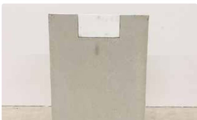
Bild 27. Väggblock med färdigskuret urtag för bräddavlopp.
