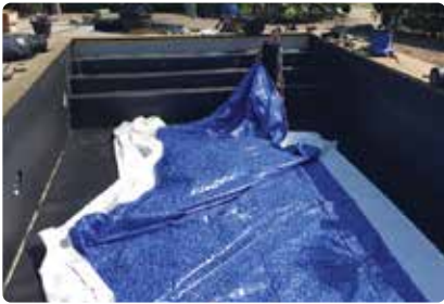
Bild 85. Linern läggs ut på poolens botten.
