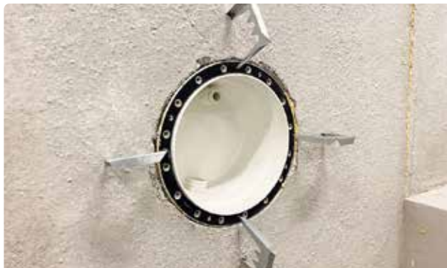
Bild 50. Använd skarvbleck för att stabilisera lampan när den ska fogskummas fast.
