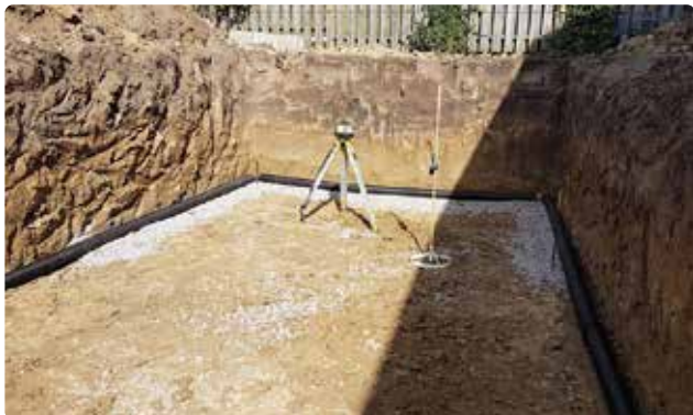
Bild 4. Lagg dräneringsrören med ett svagt fall mot brunnen.
