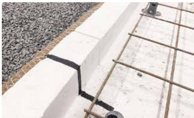
Bild 10. Markera ut på grunden vart alla pelare ska placeras.
