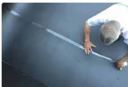
Bild 83. Tejpa skarvar med genomskinlig tejp för att undvika att duken glider.
