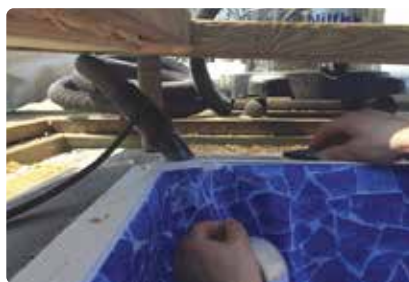
Bild 89. Dammsugarmunstycken förs in bakom linern och tejpas.
