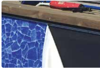
Bild 86. Linern fästs i snap-in-listen.
