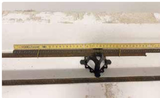
Bild 43. Armeringsjärnen ska skarvas 400 mm.
