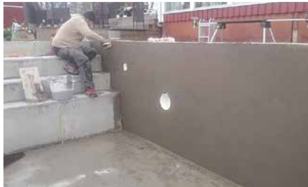
Bild 58. Vid platssvetsad liner är det vanligt att både trappa och hela insidan poolväggar ska slätputsas.
