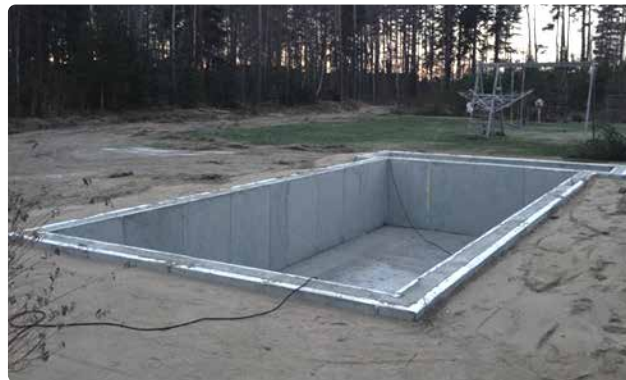
Bild 62. Helt återfylld pool.
