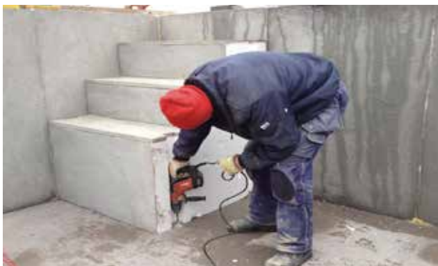
Bild 39. Expanderbult skruvas fast i betongplattan i varje urtag.
