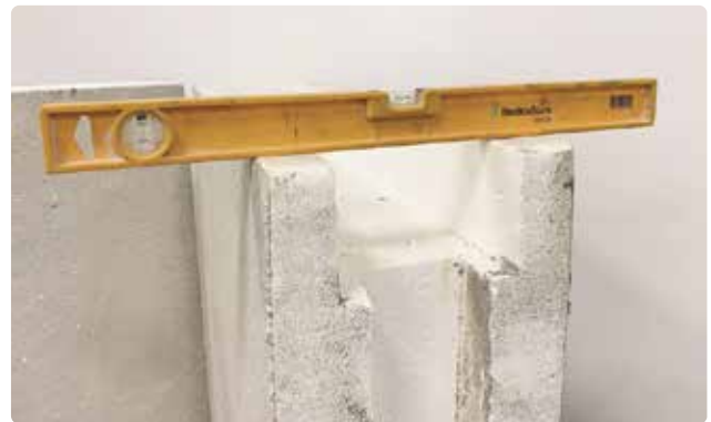
Bild 21. Kontrollera med vattenpass att väggarna hamnar i lod.
