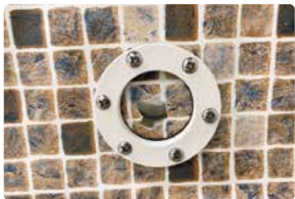
Bild 95. Mellan tätningsring och liner ligger en tätningslist.
