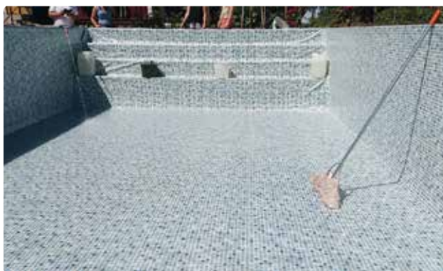
Bild 91. Rätta ut linern i botten under vattenpåfyllningen.
