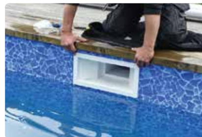
Bild 100. Frontramen monteras sedan på tätningslisten.
