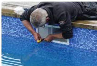
Bild 99. När tätningsramen är på plats renskär linern.
