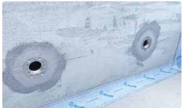
Bild 87. Ursparning vid inlopp har fyllts med Adesilex.
