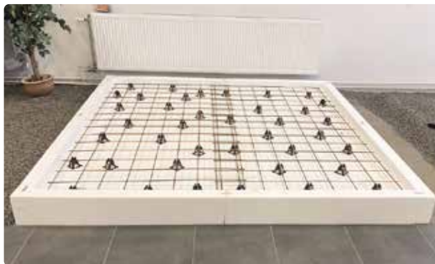
Bild 9. Armeringsnät utplacerade i grunden.
