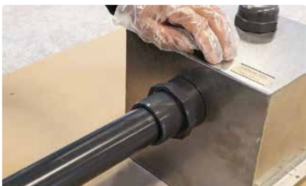
Bild 52. Limma fast PVC-röret i bräddavloppet.
