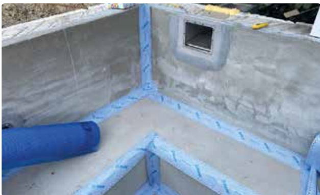
Bild 92. Mät först ut rätt längder för tätbanden.
