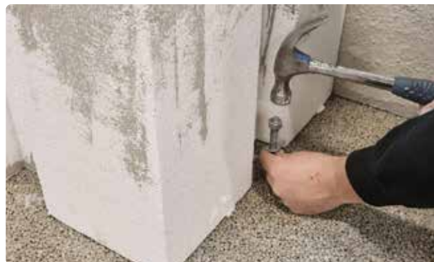
Bild 29. Slå ner en expanderbult i det förborrade hålet.
