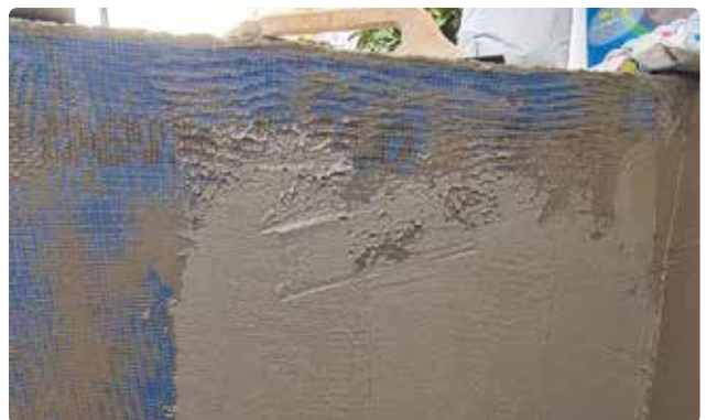
Bild 95. Tryck fast Mapenet och spackla över med Mapelastic.
