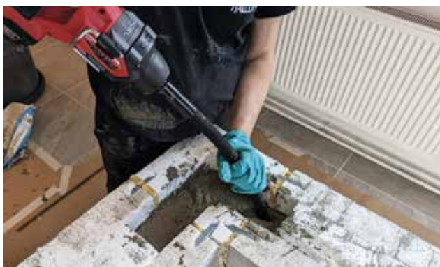
Bild 60. För att se till att betongen kommer ner ordentligt i pelarna kan en betongvibrator användas.
