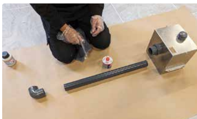
Bild 49. Delar för att limma fast PVC-rör i bräddavloppet.
