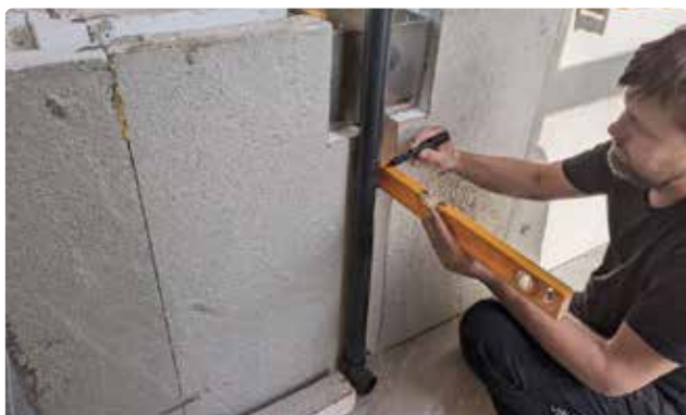
Bild 46. Markera längd på PVC-rör.
