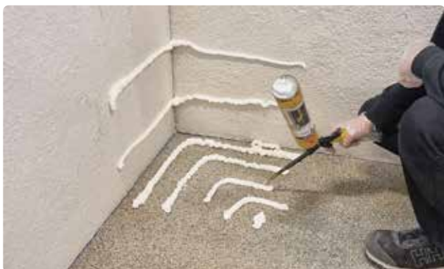
Bild 26. Börja med att fogsamma fast sittblocket i hörnet.
