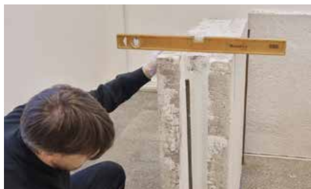
Bild 19. Kontrollera med vattenpass att väggarna hamnar i lod.
