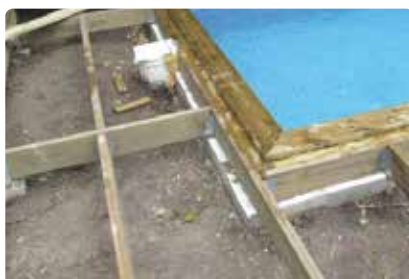
Bild 112. Träbjälkarna till trädäcket fästs i träregeln.
