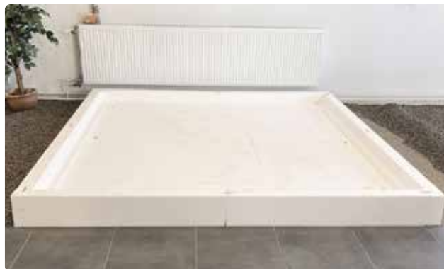
Bild 7. Innanför kantelementen läggs grundisoleringen ut.
