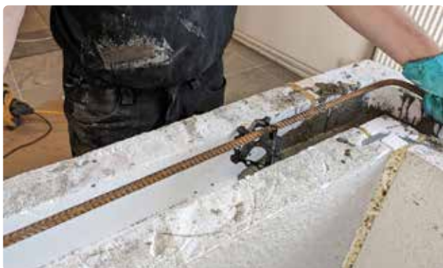
Bild 62. Montera ett armeringsjärn på armeringsdistanser i krönbalken. Använd de vinklade järnen i hörnen.
