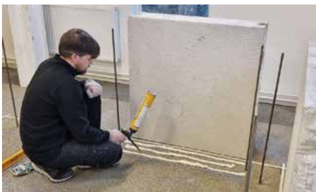
Bild 18. Lägg tre strängar med fogskum där blocket ska stå.
