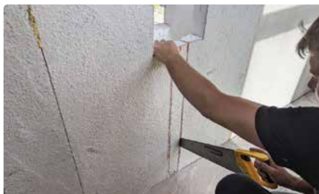
Bild 45. Skär loss cellplastremsan, försök hålla remsan intakt.
