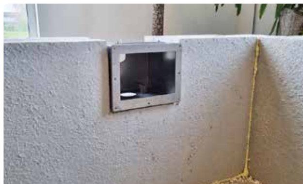
Bild 38. Kontrollera så att bräddavloppet passar i urtaget.
