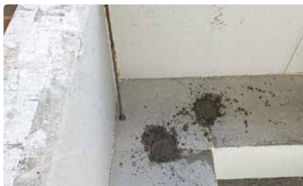
Bild 61. Ett armeringsjärn kan även användas för att arbeta bort eventuella luftbubblor i betongen.
