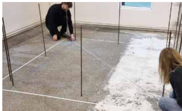
Bild 17. Kontrollera poolens diagonalmått.
