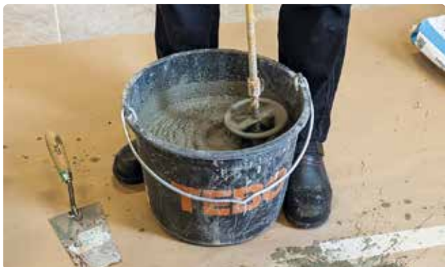
Bild 58. Betongen till pelarna handblandas med betongvisp.
