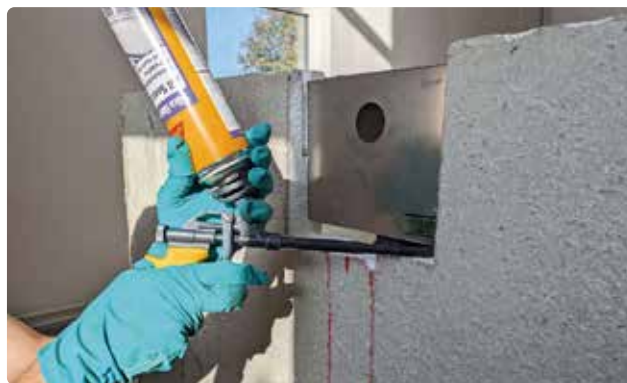
Bild 57. Skumma fast bräddavloppet i fram- och bakkant.
