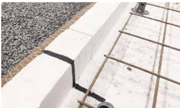
Bild 10. Markera på kantelementen vart armeringsvinklarna ska placeras.
