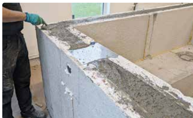
Bild 67. Färdiggjuten krönbalk.
