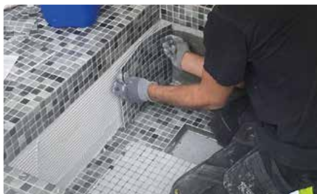
Bild 98. Tryck fast mosaiken och säkerställ god kontakt (full täckning) med fästmassan.
