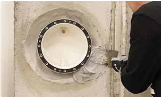
Bild 84. Adesilexmassan ska tryckas in i hela ursparningen.
