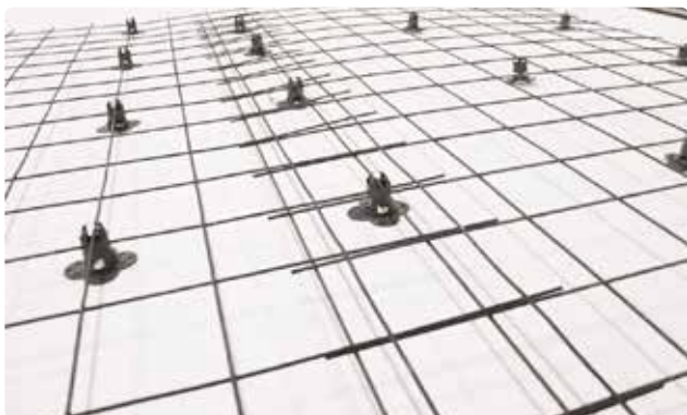
Bild 8. Armeringsnät skarvas med 200 mm överlapp.
