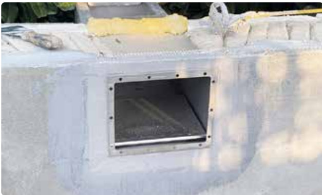
Bild 86. Ursparning vid bräddavlopp har fyllts med Adesilex.
