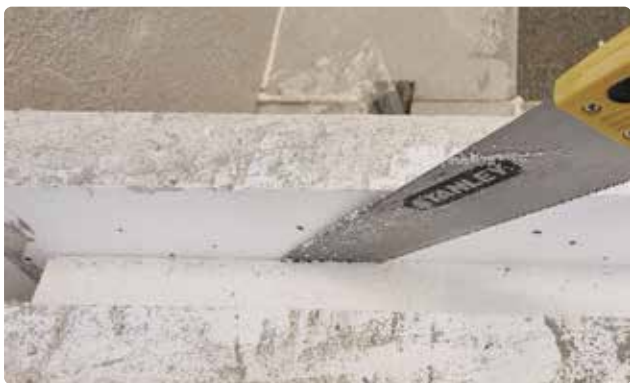
Bild 33. Skär spår i sidorna av urtaget och bryt loss cellplasten så att bräddavloppsblocket får ett djupare urtag.
