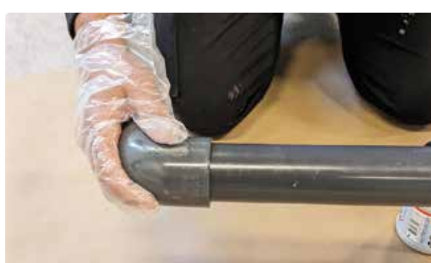
Bild 53. Limma fast PVC-kopplingen i PVC-rörets nedre del.
