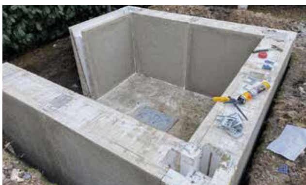
Bild 24. Resterande vägg- och hörnblock placeras ut efter den objektsanpassade poolritningen.
