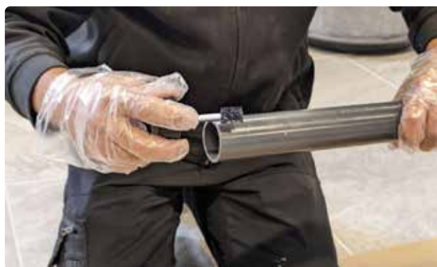
Bild 51. Applicera PVC-lim på PVC-rör- och kopplingar.
