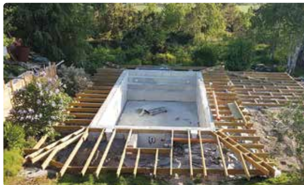
Bild 110. Trädäcket kan med fördel fästas i poolens krönbalk.
