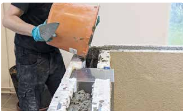
Bild 66. Säkerställ att betongen kommer ner ordentligt under bräddavloppet.
