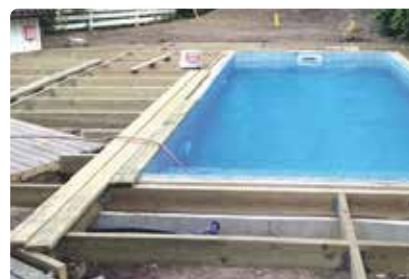
Bild 113. Plankorna till trädäcket fästs sedan i de monterade träbjälkarna.
