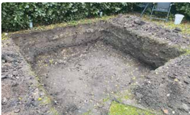
Bild 2. Grävning för spapool.
