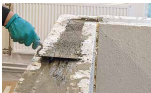
Bild 65. Använd murslev eller liknande för att ta bort överflödig betong.
