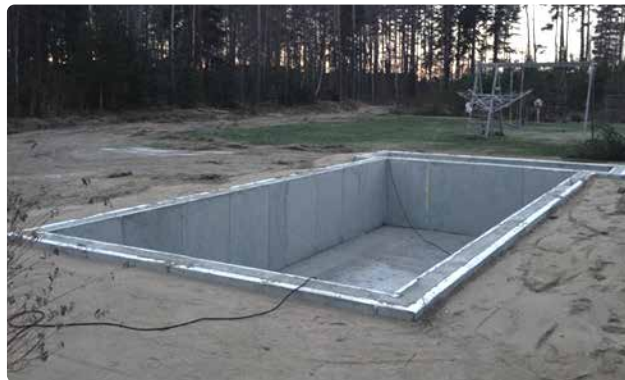
Bild 109. Helt återfylld pool.
