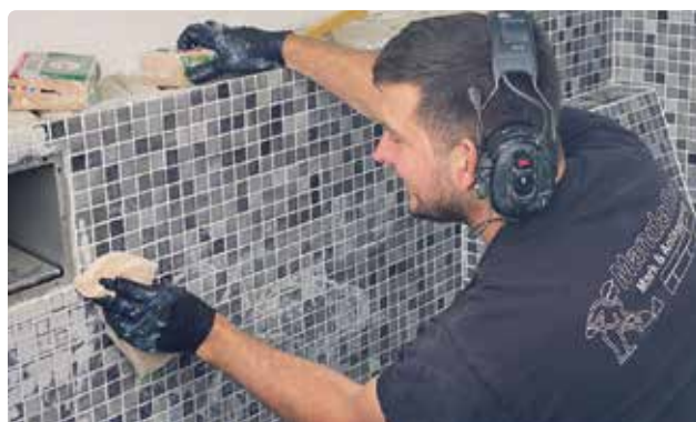
Bild 104. Rengör plattorna direkt.
