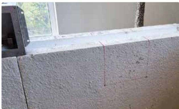
Bild 35. Mätta med bräddavloppshuset för att markera urtag.
