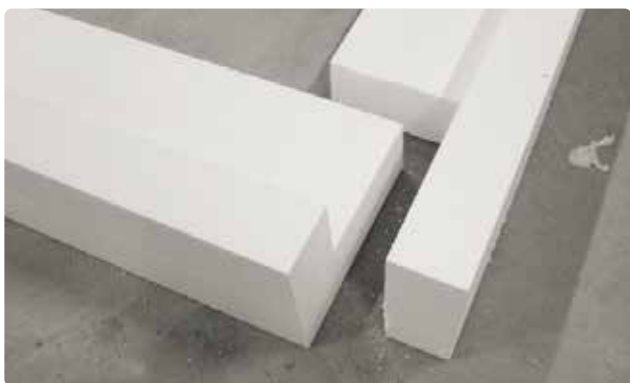
Bild 4. Skär cellplast från ett kantelement för att skapa ett hörn.
