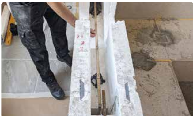
Bild 39. Mät längden på järnet som ska placeras i rännan.
