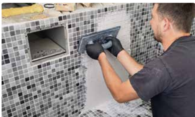
Bild 103. Applicera epoxyfog med bredspackel.
