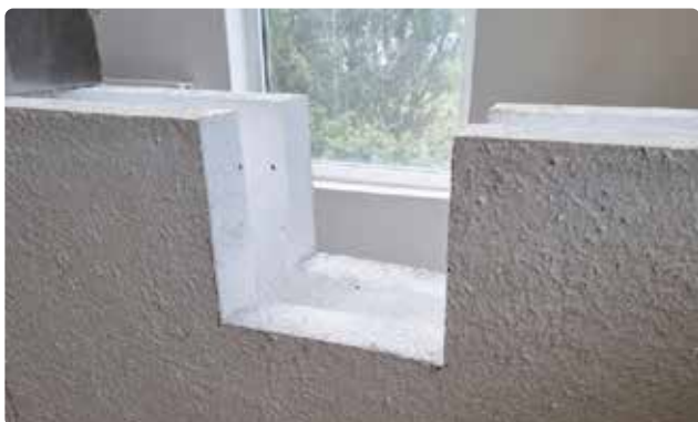
Bild 37. Urtaget ska göras både i blockets insida och utsida.
