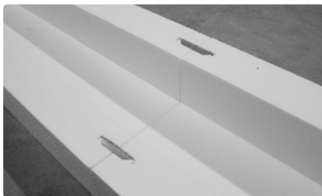
Bild 5. Fäst ett skarvbleck i ovkant och ett nere i L:et.
