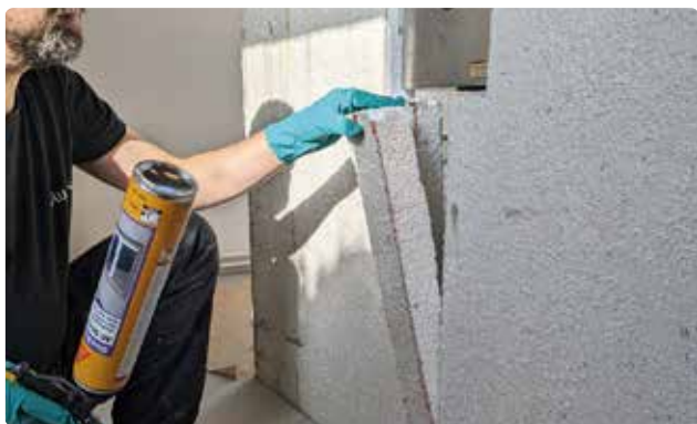
Bild 56. Skumma fast cellplastremsan på utsidan av blocket.
