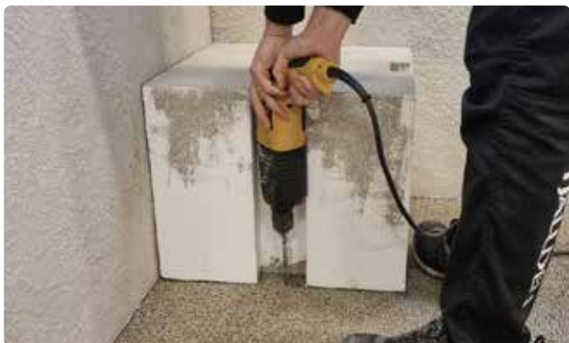
Bild 28. Borra hål för expanderbult i betongplattan.
