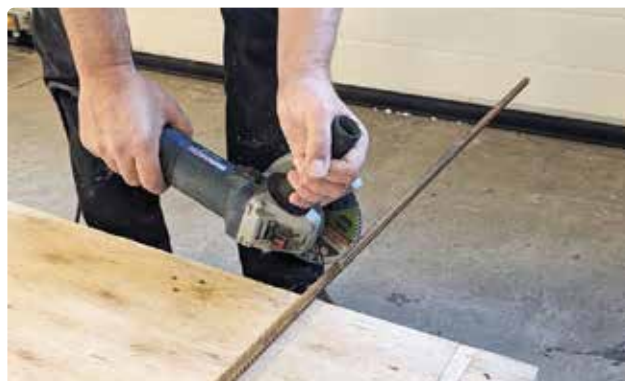
Bild 40. Skär till armeringsjärnet i rätt längd.
