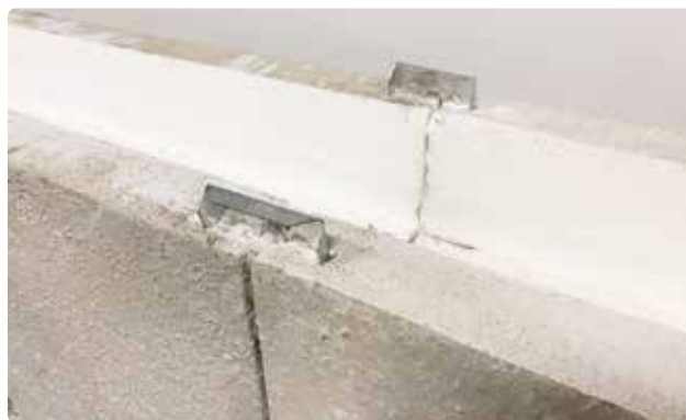
Bild 21. Fäst ihop poolväggarna med skarvbleck i ovankant.
