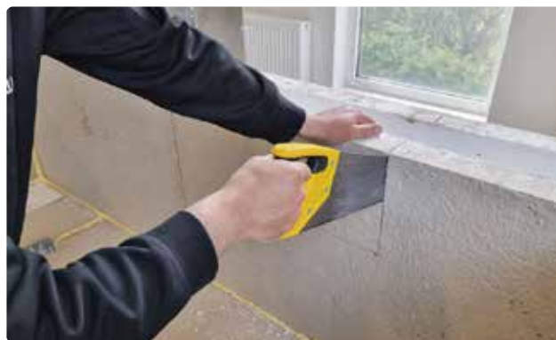
Bild 36. Skär ur för bräddavlopp.
