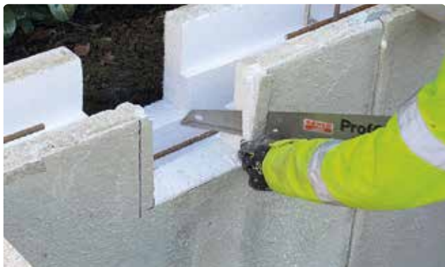
Bild 42. Skär ett konformat urtag 50×50 mm.
