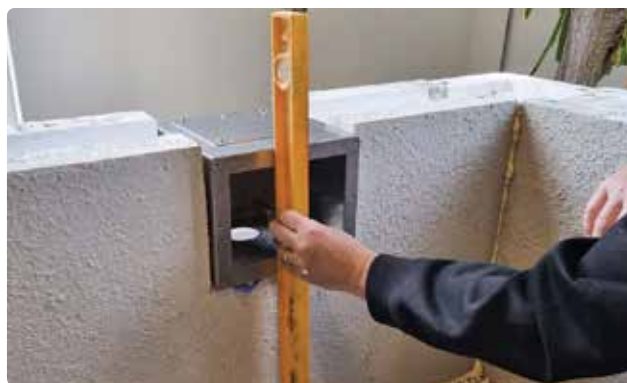
Bild 55. Använd vattenpass för att få bräddavloppet rakt.
