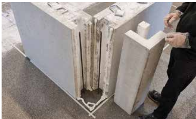
Bild 20. Skumma fast hörnblocket.
