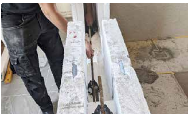
Bild 41. Montera armeringsjärnet på distanser i rännan.
