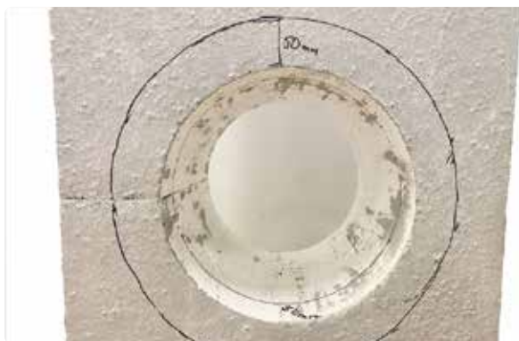
Bild 69. Mät ut för Adesilex-ursparning som ska vara 50 mm bred och 50 mm djup.
