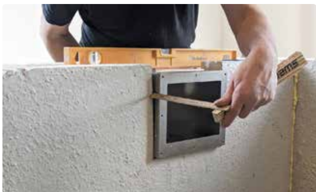
Bild 54. Mät så att bräddavloppet sticker ut så mycket som puts+tätskikt+fix+klinker/mosaik.
