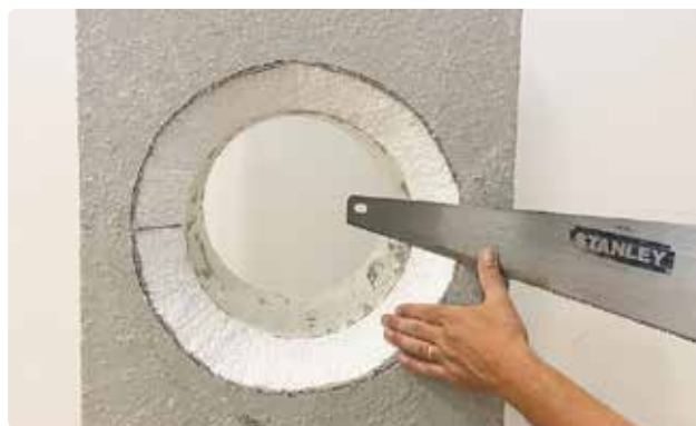
Bild 70. Ursparningen för Adesilex kan sågas med fogsvans.
