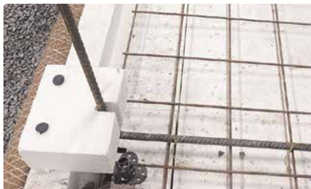
Bild 11. Använd cellplastklossarna för att stabilisera armeringsvinklarna.
