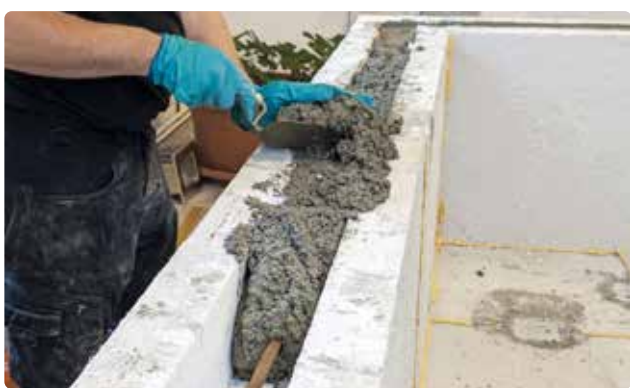
Bild 64. Se till att betongen kommer ner i hela krönbalken.
