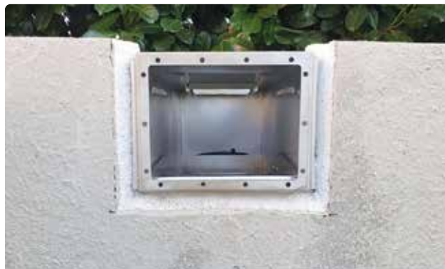
Bild 43. Ursparningen ska senare tätas med Adesilex PG1.
