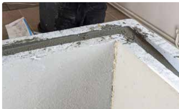
Bild 63. Fyll krönbalken med betong.
