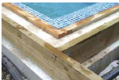
Bild 111. Cellplasten skärs ner och träreglar fästs runt poolen.
