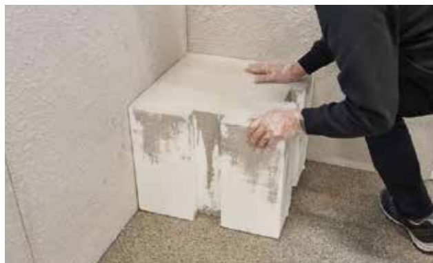
Bild 27. Montera sittbänken med lätt tryck en stund.
