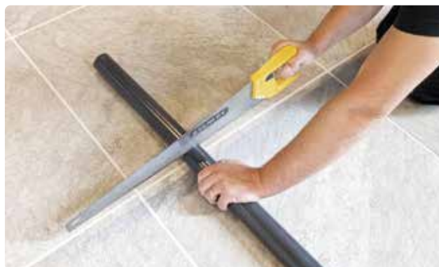
Bild 47. Kapa PVC-röret i rätt längd
