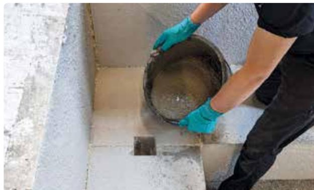
Bild 59. Pelare till sittbänk och väggar gjuts.
