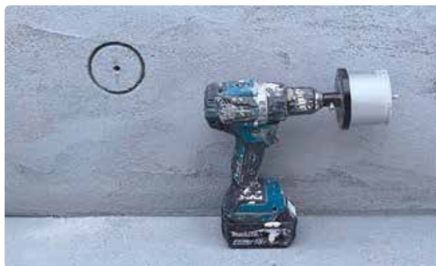
Bild 68. Använd exempelvis en dosborr för att göra hål för inlopp och spotar.
