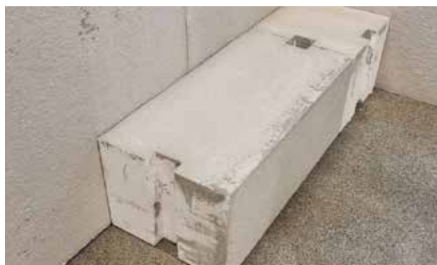
Bild 31. Sittblocken skummas fast ett i taget.
