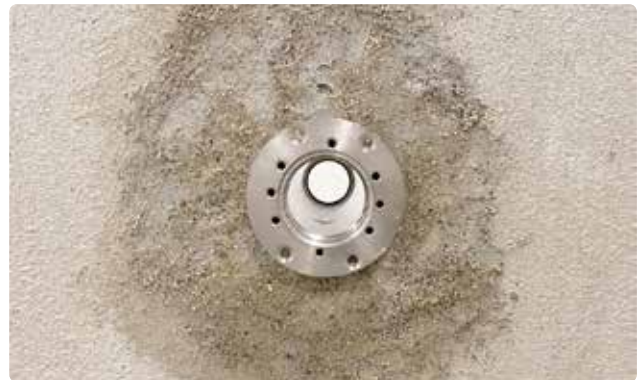
Bild 85. Adesilexmassa runt ett inlopp. Avsluta med ett fint lager sand på ytan in mot pool.
