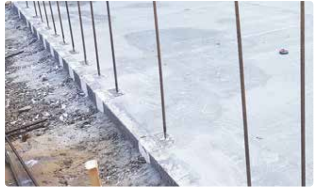
Bild 15. Cellplastklossarna plockas bort när betongen härdat.
