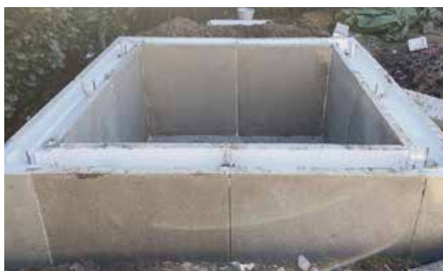
Bild 25. Se till att de armeringsvinklarna som sticker upp från plattan hamnar så centriskt i urtagen som möjligt.
