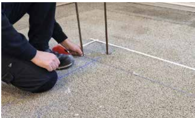
Bild 16. Markera poolens innermått med t ex ett färgsnöre.
