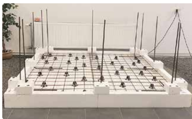
Bild 13. När armeringsvinklarna är på plats är grunden klar för gjutning.
