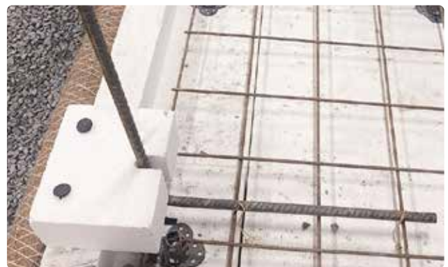
Armeringsjärnen som binder ihop platta och väggar är vinklade för att få en stark förankring.
