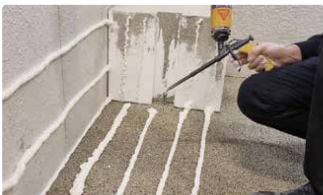
Bild 30. Forstått skumma fast de resterande sittblocken.
